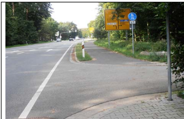
Ortsende- Waldweg Dietzenbach, mit Blick auf den benutzungs-pflichtigen gemeins. 2- Richtungs- Geh- Radweg. Die fahrenden Radfahrer müssen die Fahrbahn neben dem Gehweg benutzen und den durchgezogene Breitstrich überfahren, um nach Norden zu kommen!
