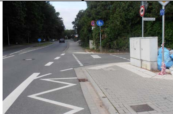
Lerchenstraße- wie Jägerstraße, aber Haltelinie mittig in Fußgänger- Furt, Hier endet die Freigabe der Gehwege für den Radverkehr! Radverkehrsführung fehlt
