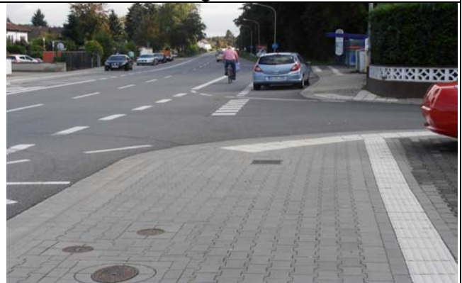
Am Kappenwald- unterbrochener Breitstrich und Wartelinie, keine Radverkehrsführung zum beginnenden Radfahrstreifen nach Süden
